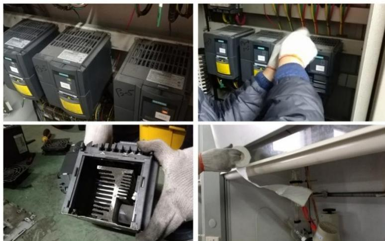
对电控箱进行维护保养，保证整套通风控制系统的安全稳定和使用寿命。（王瑞寅）
